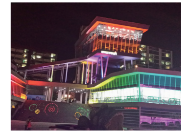
전기 인테리어 공사
